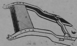
Parte trasera, mostrando los fuertes travesaños y plancha de refuerzo.
